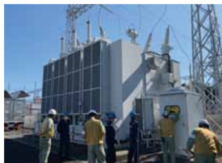
変電所の立入検査
