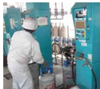
LP ガス充填所
