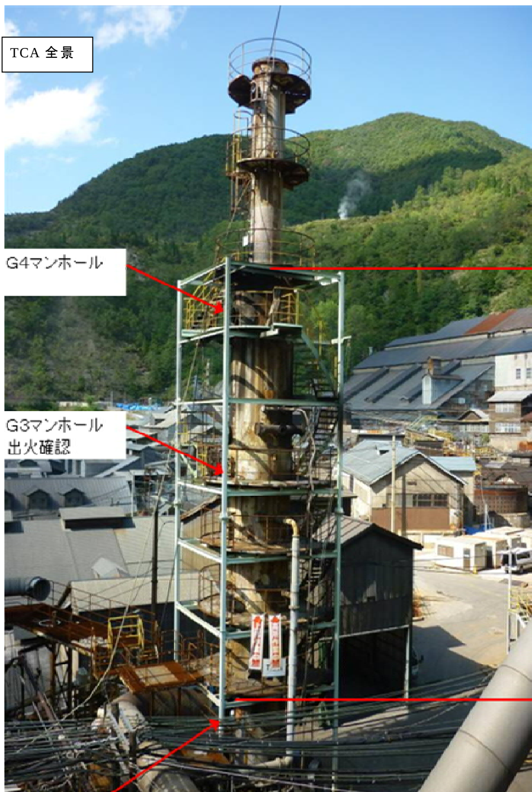
入口煙道補修工事 出火位置
