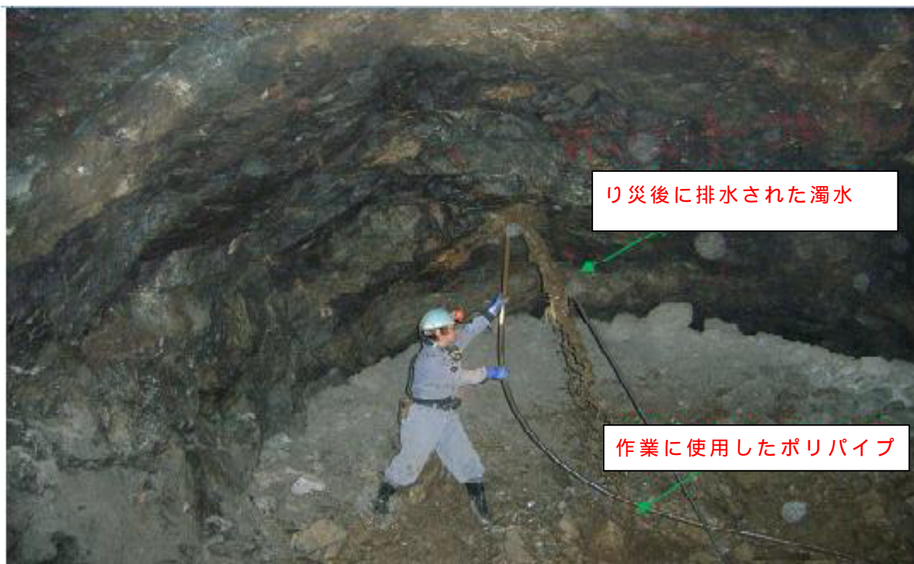
り災前の作業状況（再現）
