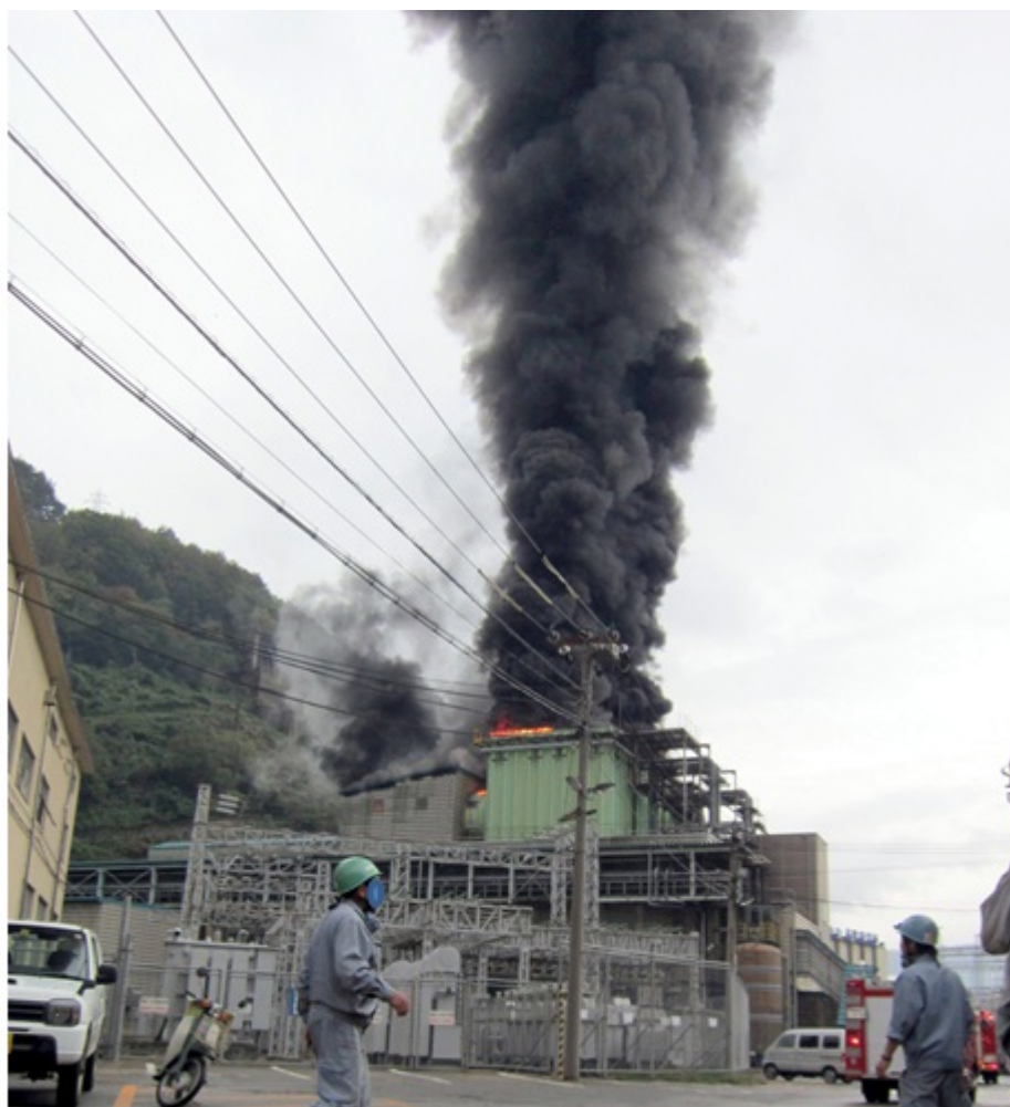
火災発生直後の状況
