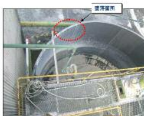
汚泥貯留槽上部
