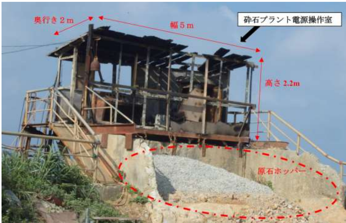
火災発生現場
