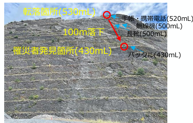
罹災者転落推定箇所及び発見箇所（352mLより撮影）
