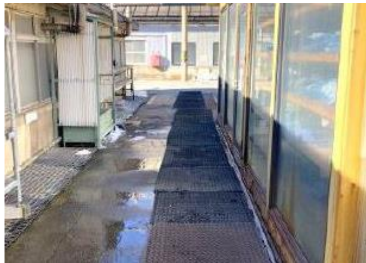
災害発生箇所の通路に転倒防止用のゴムマットを設置した。
