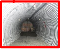
② 坑道内整備 (暗渠排水設置、路面整備)
