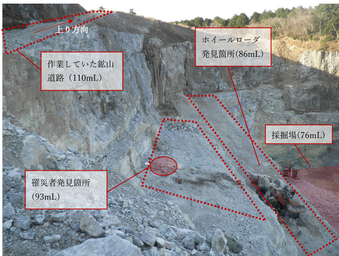
写真1 災害発生現場
