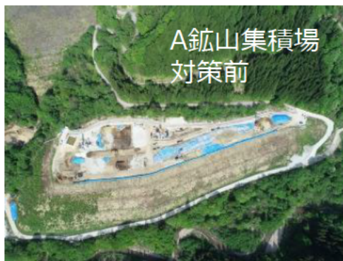
【集積場の耐震化対策工事の事例】
