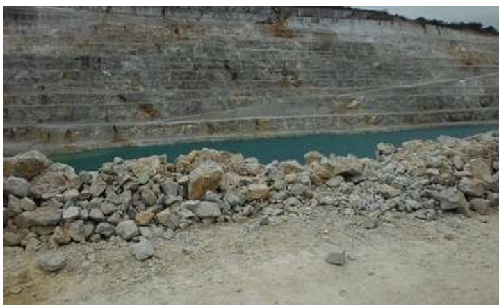
転落時の土盛り通過箇所 (土盛りが削り取られている)
