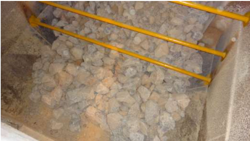
シュート足場に安全柵を設置
