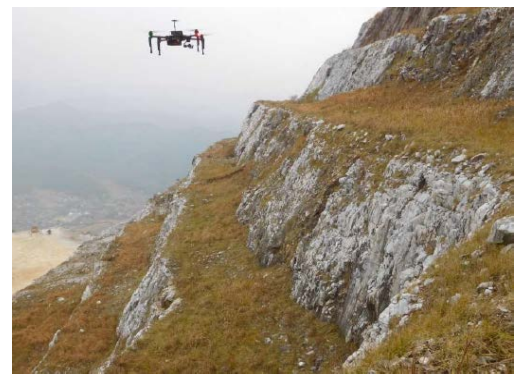
（残壁の浮石点検）
