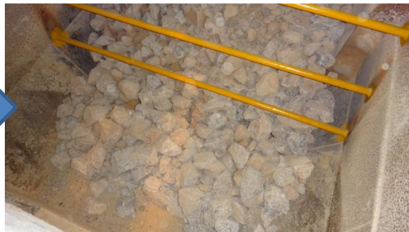
シュート足場に安全柵を設置
