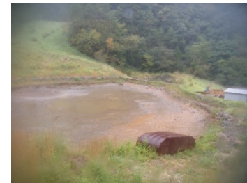
非常用沈殿池
