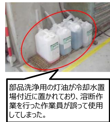
溶断作業中に水と間違えて灯油を掛け出火（令和2年10月）
