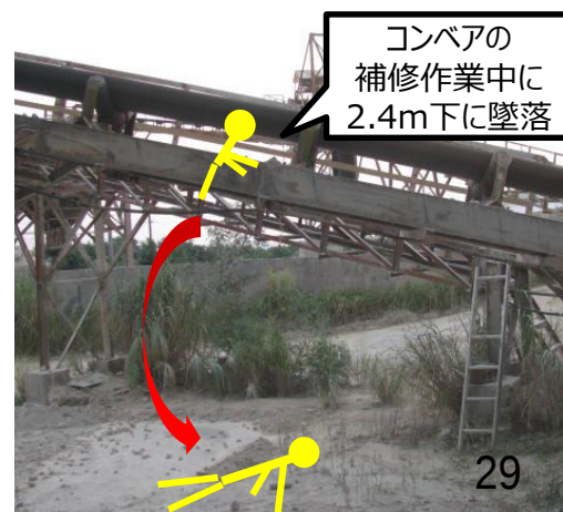
設備からの墜落（令和2年10月）
