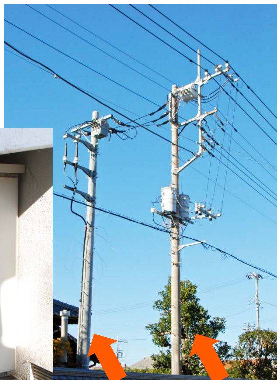
自家用架空引込柱 (6,600ボルト受電)
