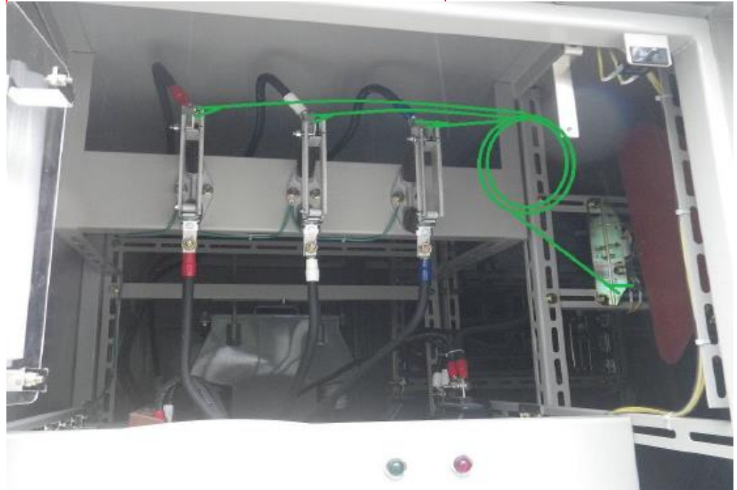
3線短絡接地器具取付位置
