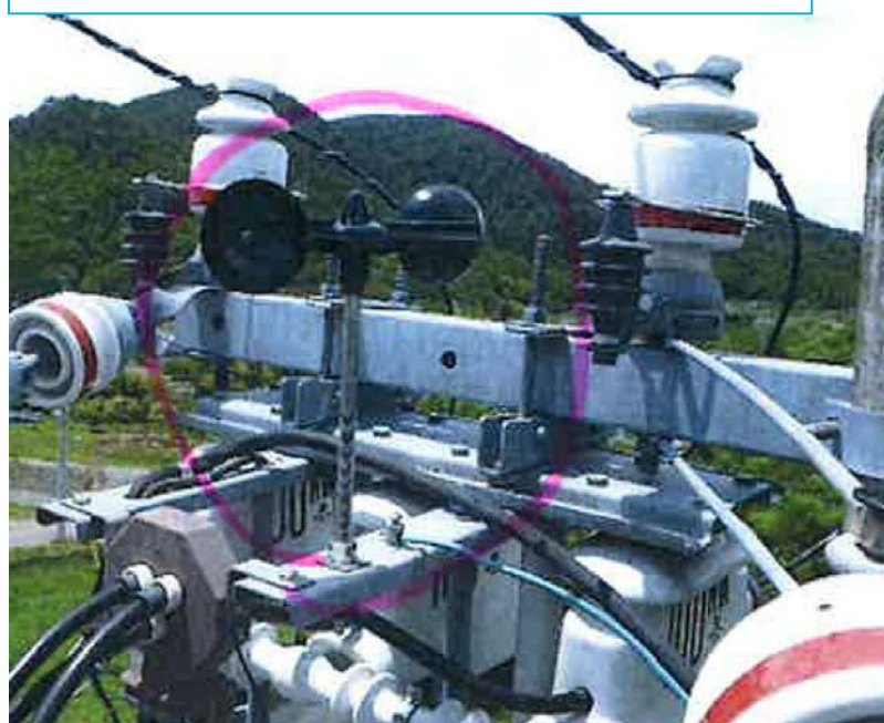
鳥害対策品(ーで囲んだ範囲)取付後
