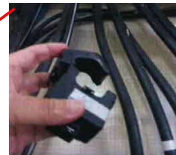
CT取付作業
